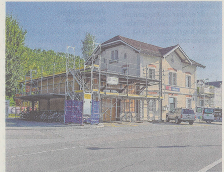
Sanfte Sanierung: In Feldbach laufen derzeit Bauarbeiten.
